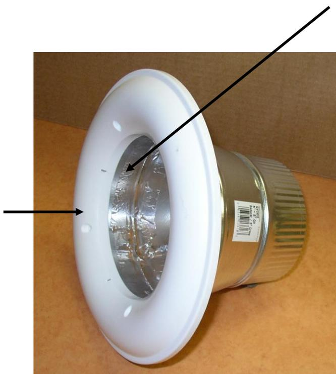
Installer du ruban adhésif d'aluminium sur les joints entre les pièces à l'intérieur du raccord 6-5 pour réduire la friction
