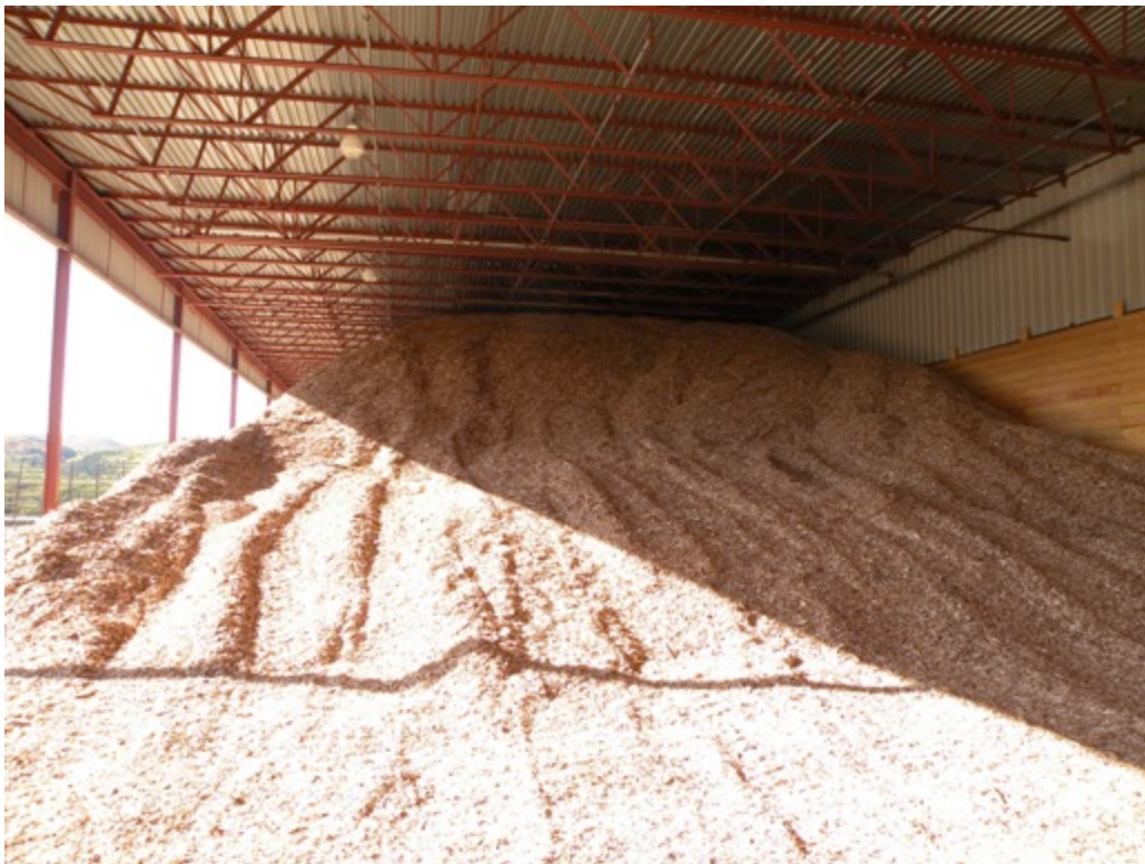
Entrepôt à plaquettes conditionnées au centre de transformation et de conditionnement de la biomasse de la Coopérative forestière de la Matapédia
