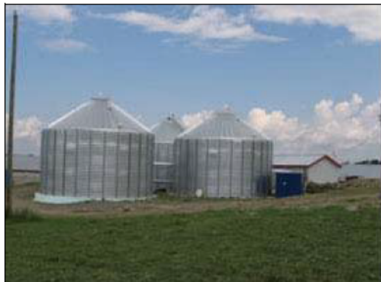
Figure 4-1 Biodigesteurs isolés thermiquement
