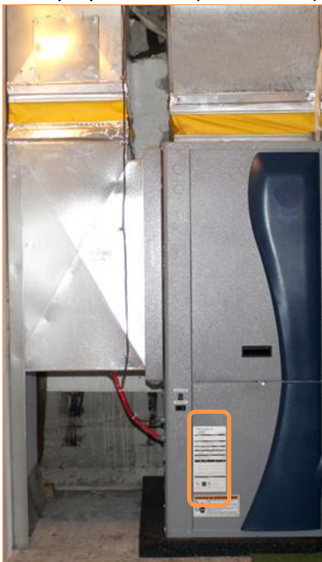
Exemple d'unité intérieure d'une thermopompe à air bibloc (dite « centrale »)
